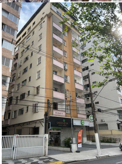
Fig. 01 a 03 - Localização Topográfica do Imóvel vistoriando em foto aérea de satélite. No círculo da ilustração à acima e à esquerda, vemos a região no bairro do Boqueirão, sua distância próxima à Av. Conselheiro Nébias à direita. À baixo vemos sua fachada, na Rua Gov. Pedro de Toledo, que confere à propriedade excelente localização urbana.
